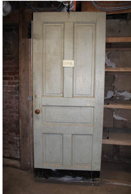
Original door (CL03B)
